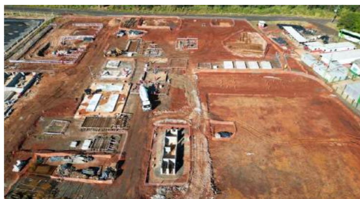
Vista área planta em construção da Biometano Sul - RS
