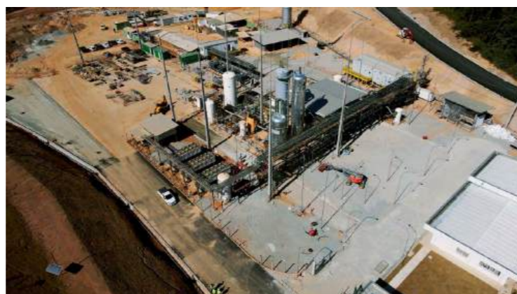
Vista área planta em construção da Biometano Caieiras - SP
