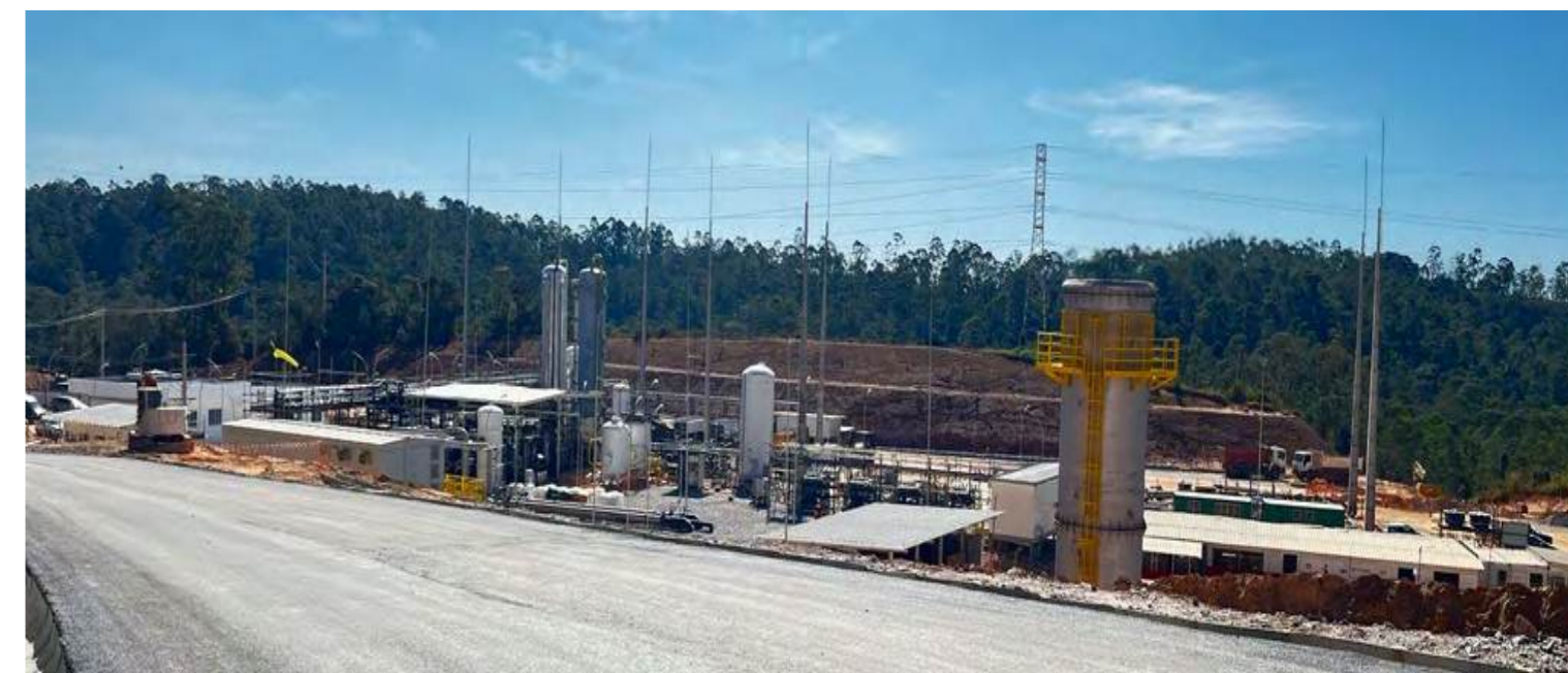
Construção da planta de Biometano Caieiras - SP
