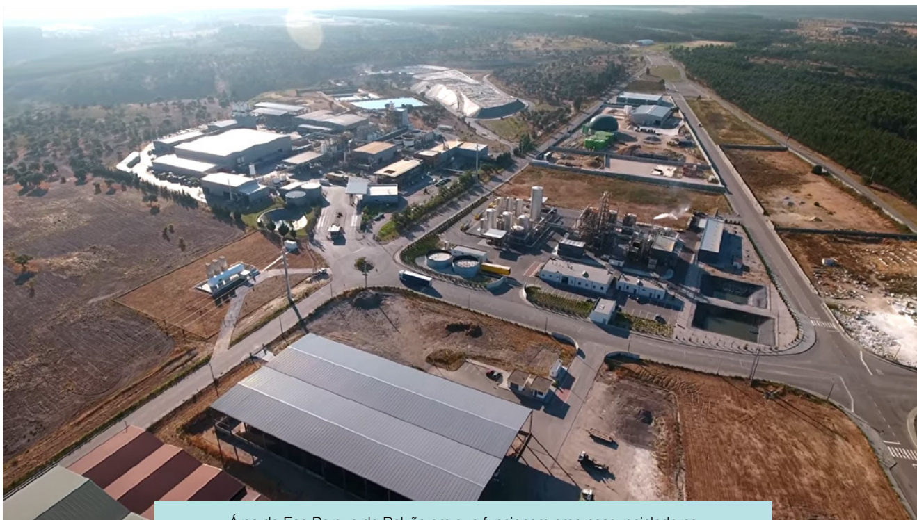
Área do Eco Parque do Relvão em que funcionam empresas recicladoras
