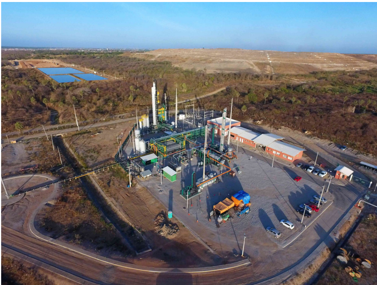
Área do Aterro de Caucaia, operado pela Marquise, onde funciona a usina para geração de energia elétrica.
